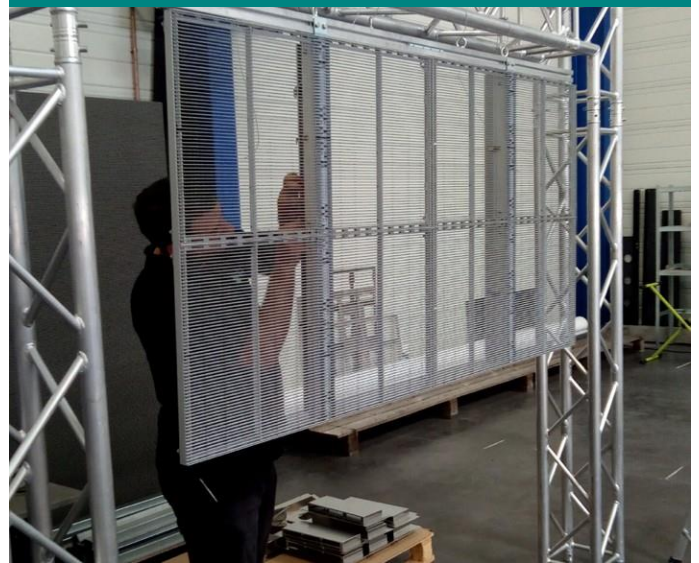
Installation NS au départ du sol
